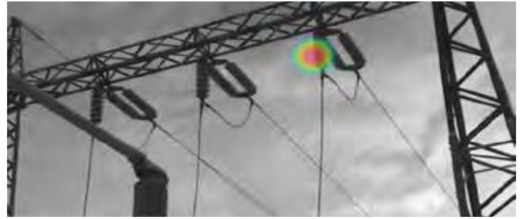
Exemple d'évaluation de la gravité de la Si124 PD
