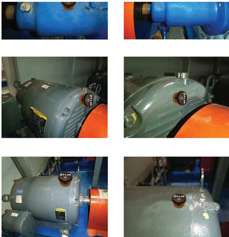
Figure 10.2 Capteurs montés sur une machine.
