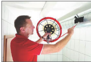
Imm. 36: Nettoyage d'un conduit d'air
