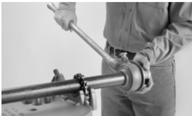
Figura 3 – Montaje de la Roscadora en el tubo
