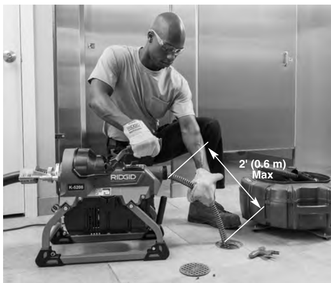
Figura 9 – El operario en posición de trabajo
