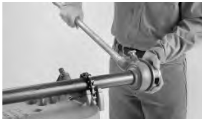
Figure 3 – Montage de la fileteuse sur le tuyau
