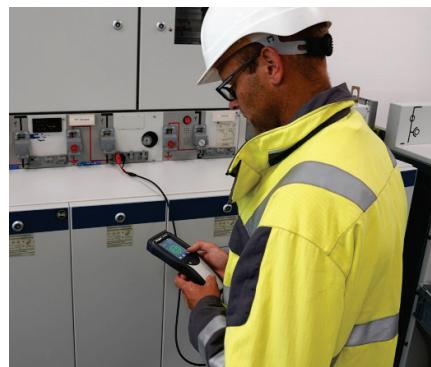
Les niveaux de DP eux-mêmes ne sont pas très significatifs pour ce type de mesure. Il faut plutôt vérifier le diagramme PRPD pour voir s'il y a des groupements ou des modèles de DP.
